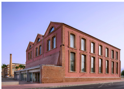
JUAN ANTONIO ISLA CASTILLO Una segunda vida. Nave de "la cocina" restaurada y chimenea principal. Fábrica de Azúcar de Nuestra Señora Del Carmen. Torre del Mar. Fotografía digital
