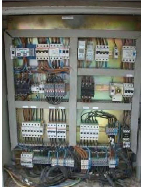
El funcionamiento de las lámparas lo inicia una fotocélula a través de un contactor.
