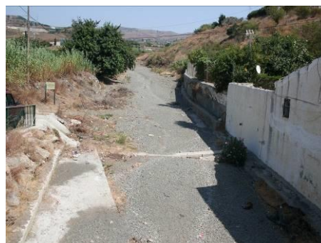
Figura 53: Vista del cauce aguas arriba de la estructura.
