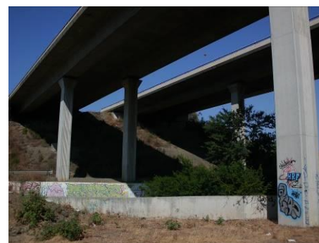
Figura 39: Viaducto de la A-7
