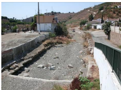
Figura 52: Vista del cauce aguas abajo de la estructura
