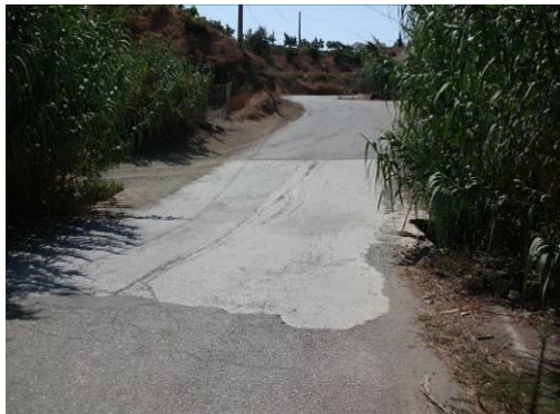
Figura 45: Vaguada sobre la que se ubica la ODT
