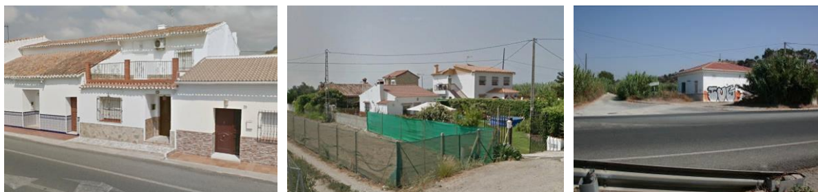
Figura 59: Viviendas afectadas por la llanura de inundación del arroyo El Búho.
