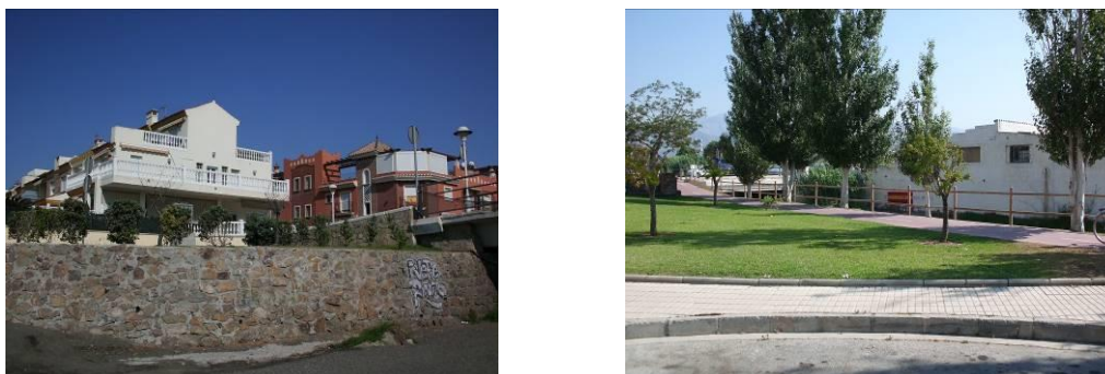
Figura 56: Viviendas con grave riesgo de inundación en la desembocadura del río Seco.
