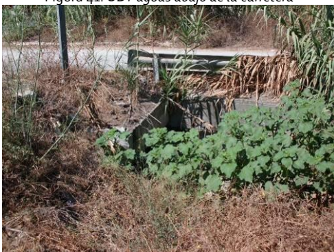
Figura 43: ODT aguas arriba de la carretera
