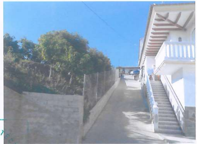
Foto 8: Límite norte de la U.E. en su zona oeste, calle Álamo
