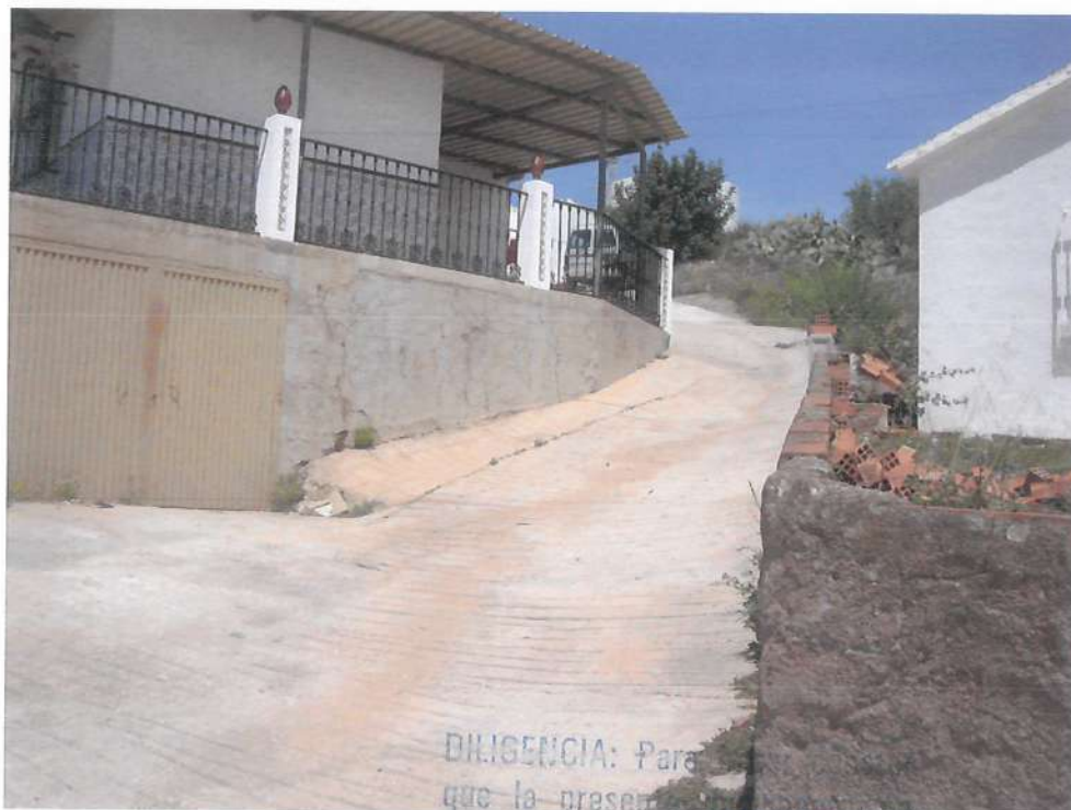
Estado actual del inicio del vial 10 (vial mixto de acceso restringido)
