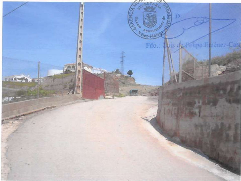
Estado actual del vial 1 en su tramo último
