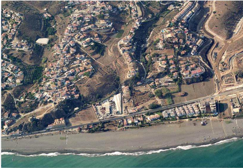
Figura 12: Tejido de ciudad extensiva de baja densidad residencial, Benajárfes Costa (Vélez Málaga)
