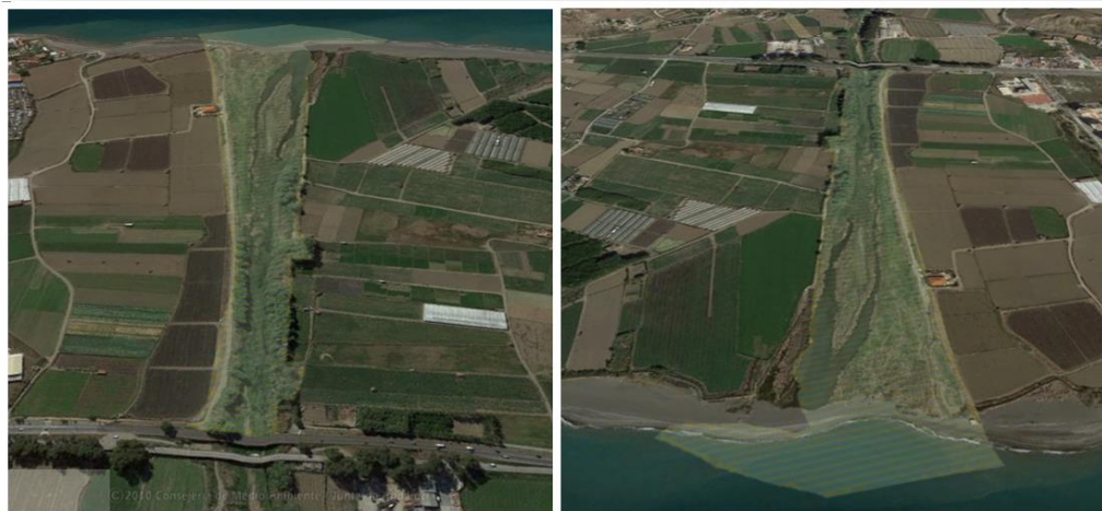
Figura 108: Ámbito del humedal "Desembocadura del río Vélez"
