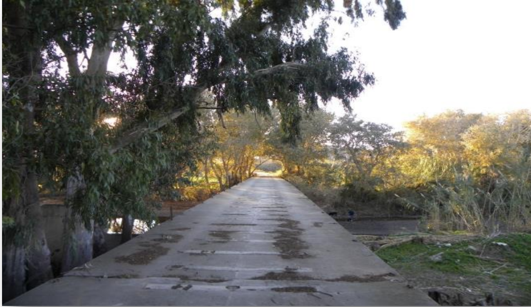
Figura 26: Puente del antiguo ferrocarril a su paso por el Río Vélez
