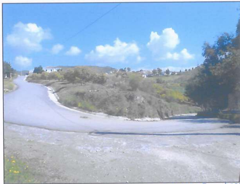
Vista del trazado curvo del camino desde el arroyo "Adelfas"
