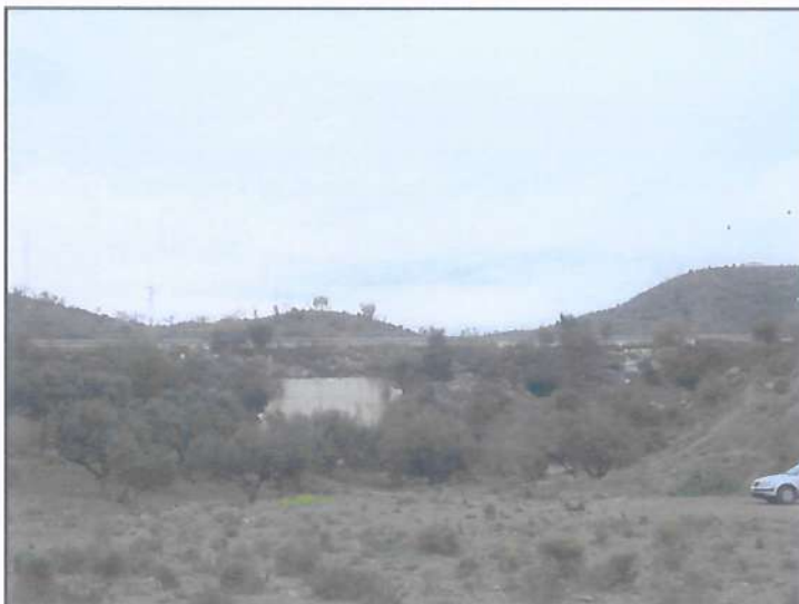
Colector de drenaje por debajo de la autovía
