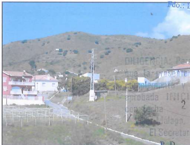
Centro de transformación en la parcela catastral nº186
