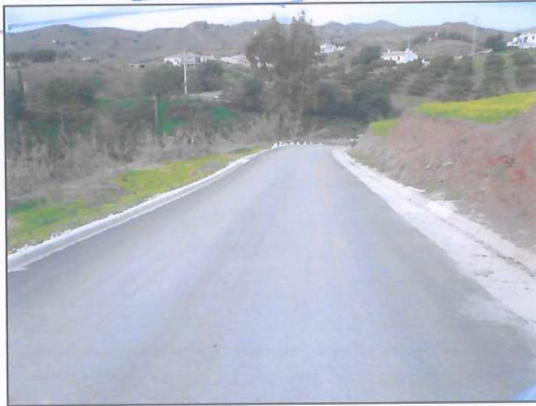
Vista hacia el norte del vial desde la carretera "Camino de Benajárfate Alto" hasta el arroyo "Adelfas"
