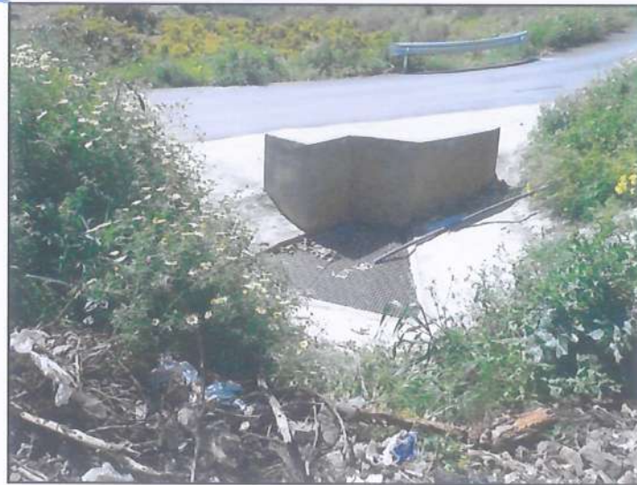
Colector de drenaje bajo la vía pecuaria
