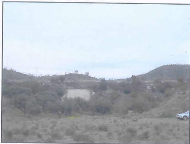
Foto 15: Colector de drenaje superficial bajo la autovía
