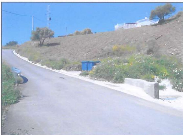
Vista del sumidero de recogida de aguas
