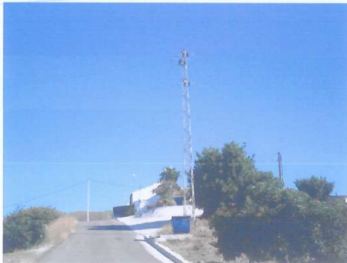
Poste junto al camino donde se realizará la bifurcación a la finca y al centro de transformación existente.
