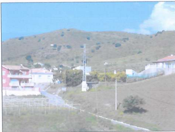
Foto 17: Centro de transformación en la parcela catastral nº186
