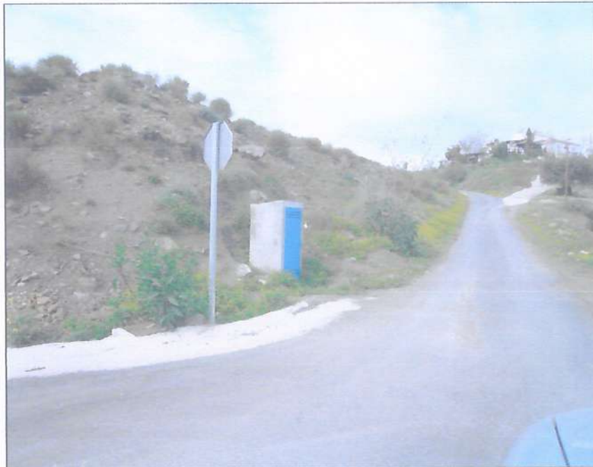
Vial desde el cruce de la vía pecuaria hasta la finca
