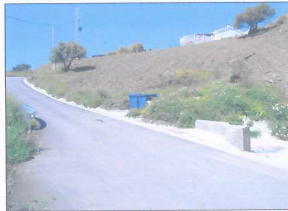
Foto 6: Vista del sumidero de recogida de aguas superficiales en la vía pecuaria
