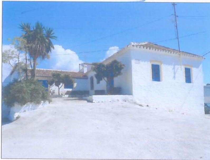
Vista de la antigua panadería
