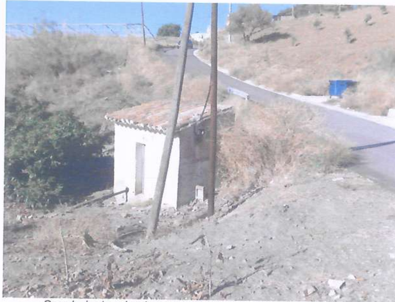
Caseta junto a la vía pecuaria donde está ubicado el pozo
