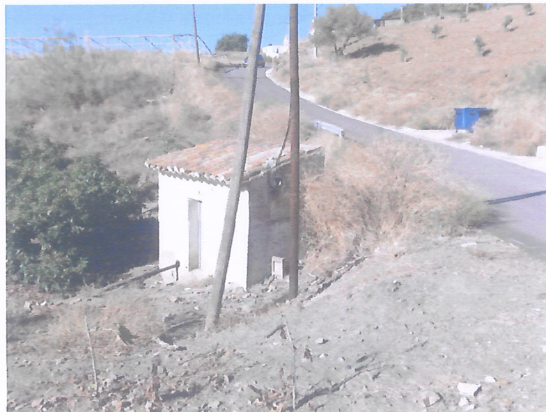
Caseta junto a la vía pecuaria donde está ubicado el pozo
