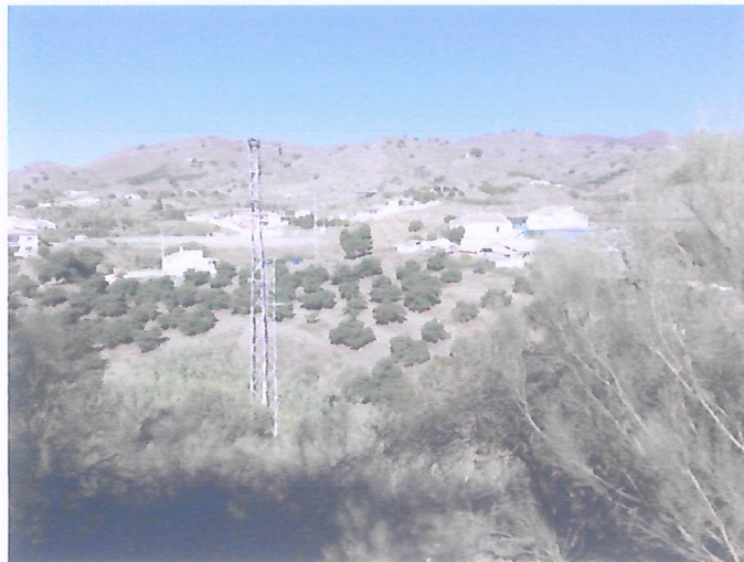
Poste desde el que se ha de hacer la conexión y línea a sustituir
