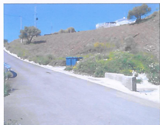
Foto 6: Vista del sumidero de recogida de aguas superficiales en la vía pecuaria.
