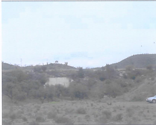
Foto 15: Colector de drenaje superficial bajo la autovía
