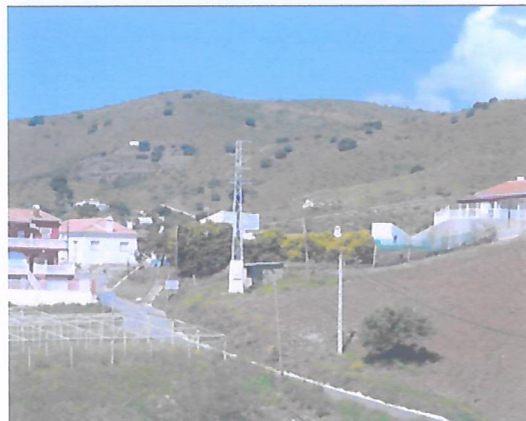
Foto 17: Centro de transformación en la parcela catastral nº186
