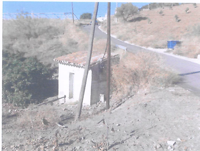
Punto de recogida de basuras en el lindero sur de la finca con la vía pecuaria, .
