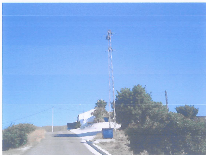
Poste junto al camino donde se realizará la bifurcación a la finca y al centro de transformación existente.
