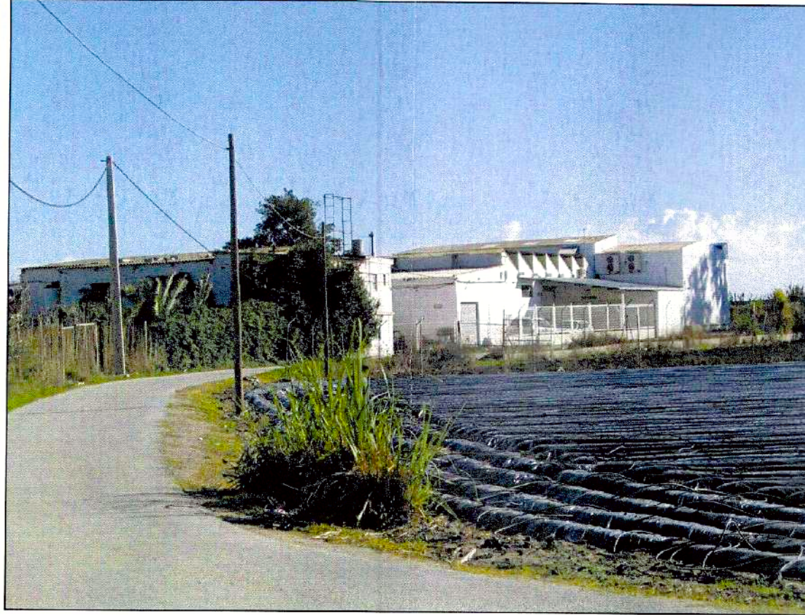
LE/F1 - LINEA ELECTRICA.
