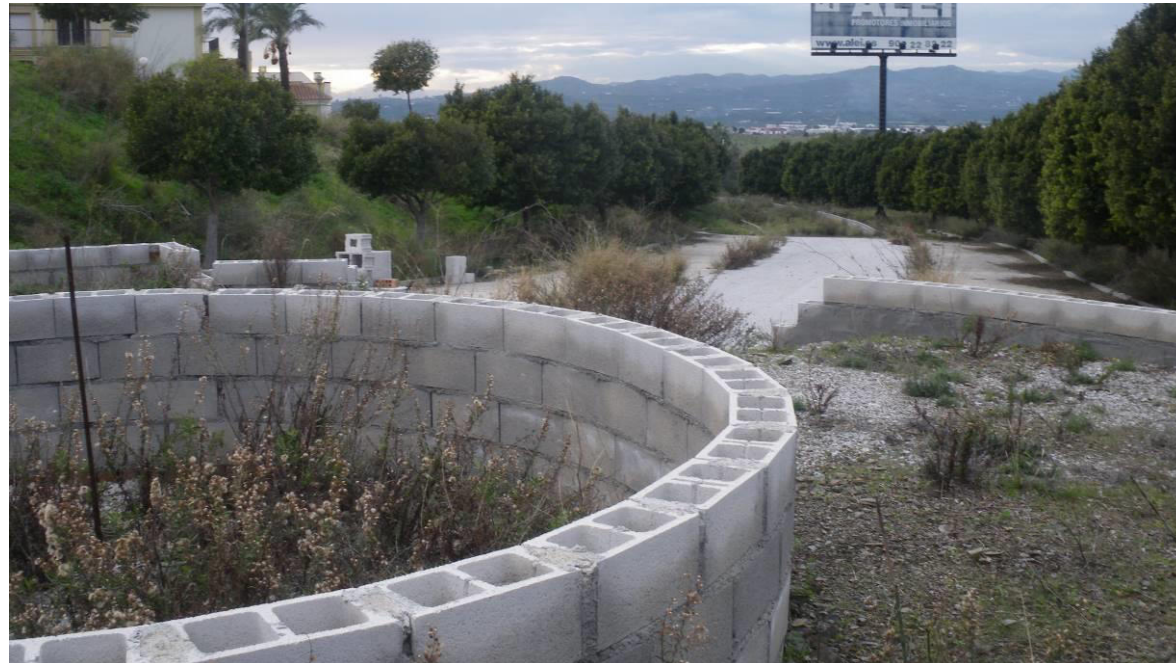
Vista general vial dirección oeste
