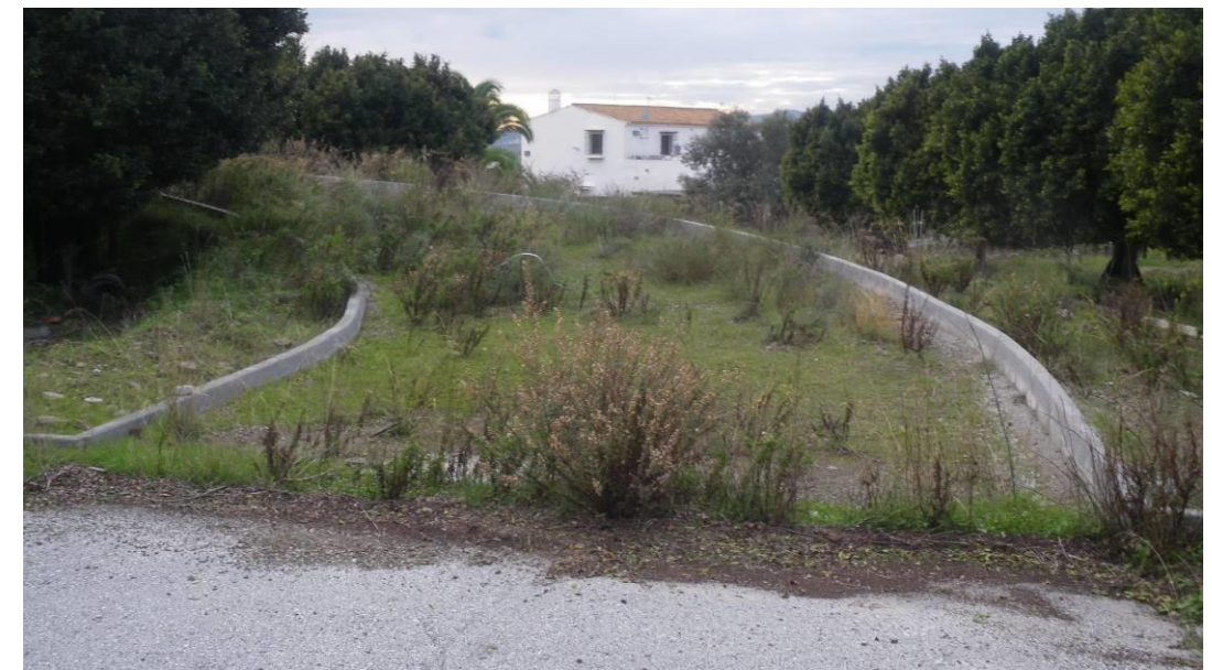
Estado actual vial acceso
