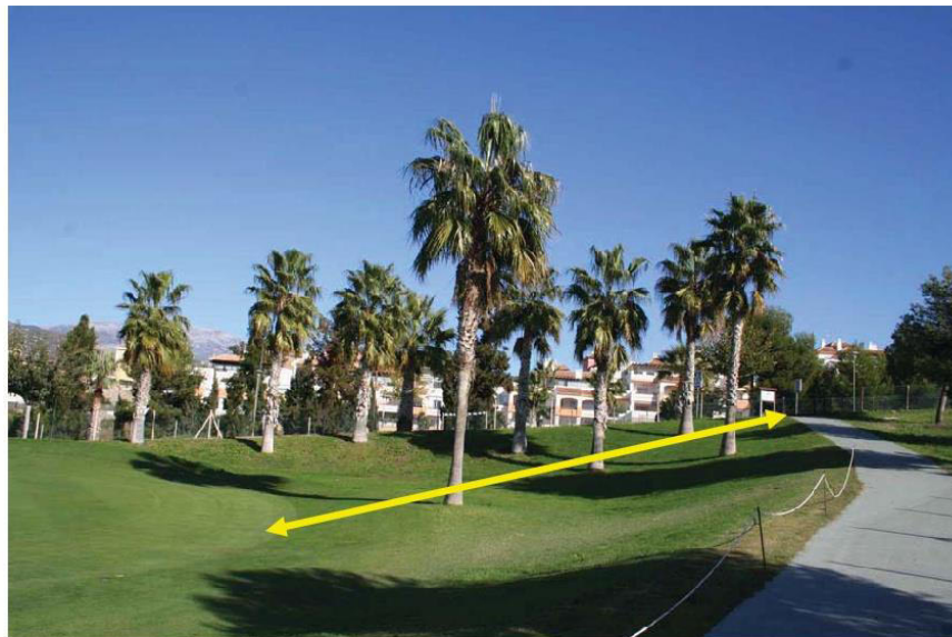
Green Hoyo 9 – Talud trasero y zona de escapatoria tras el Green. Plataforma de Green situado a cota más baja que el Vial-3 .
