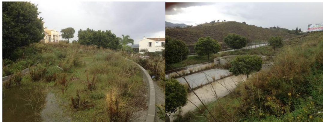
Vista del estado actual de la zona verde nº4
