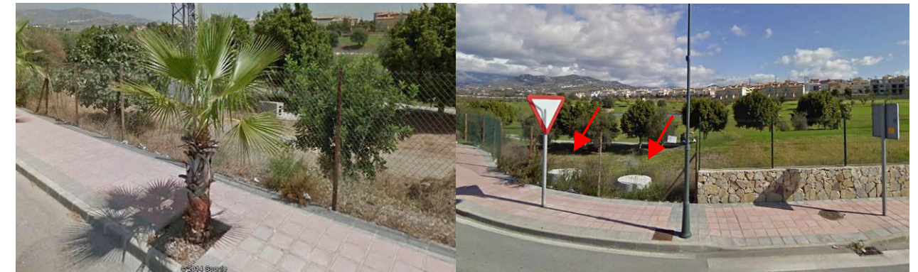
Almbrada y dados de cimentación existentes a demoler
