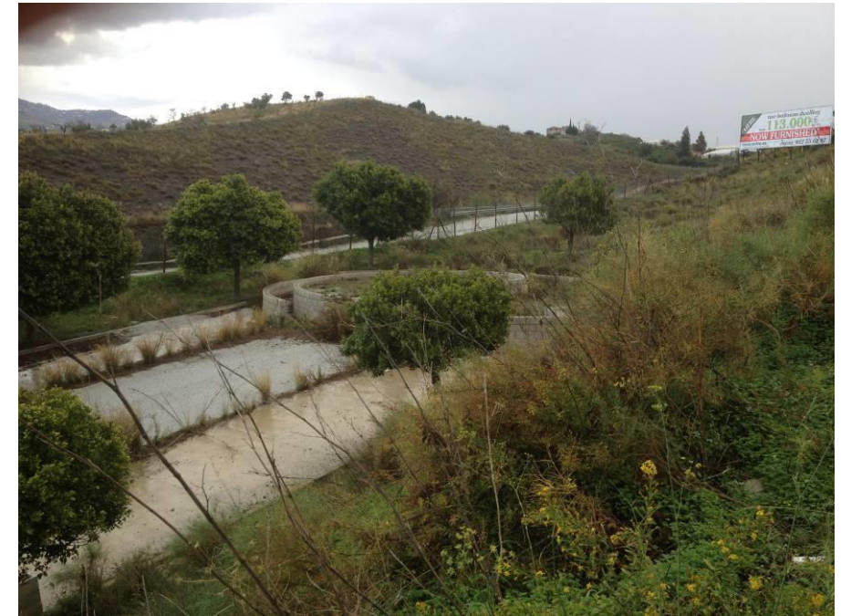
Vista general estado actual
