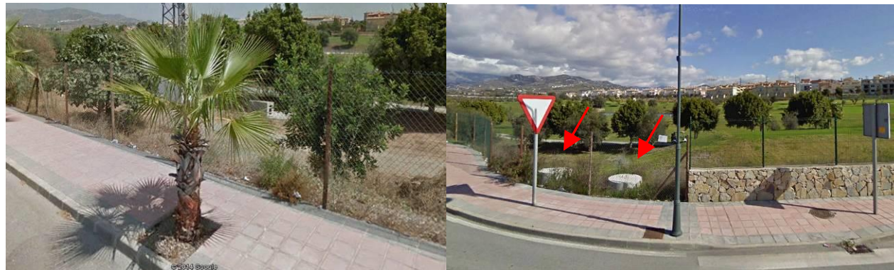
Alambrada y dados cimentación existentes a demoler
