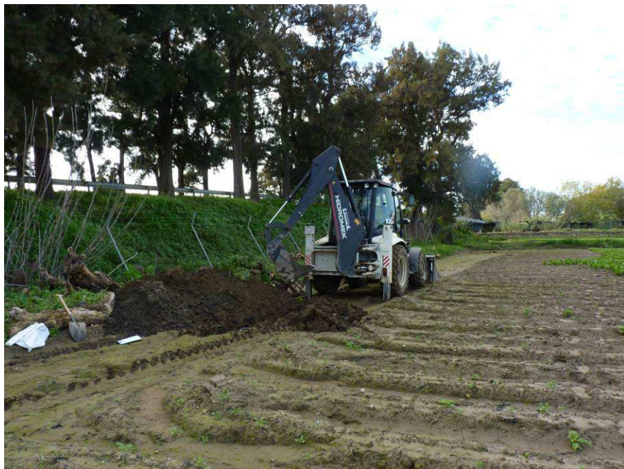
Figura Nº 32.- Emplazamiento de la cata C-07 NORTE.
