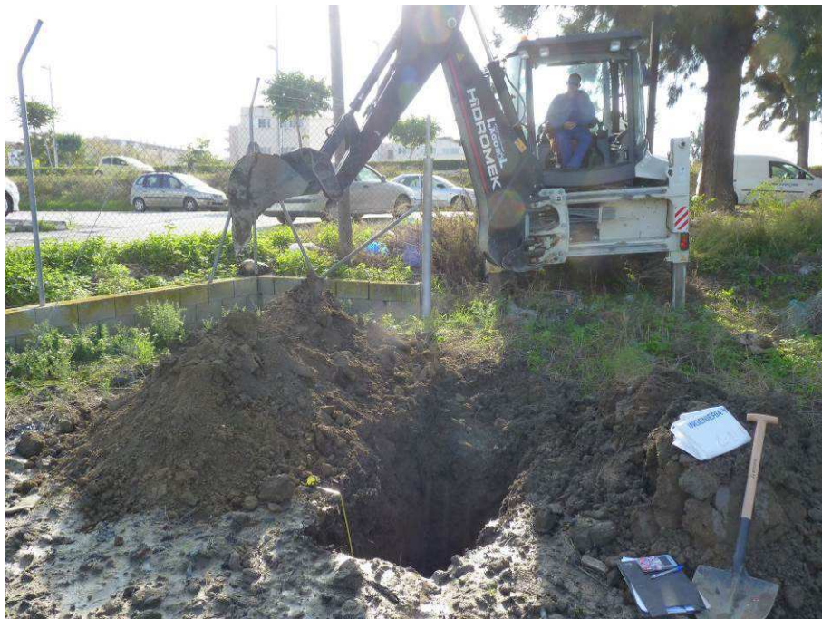
Figura Nº 26.- Emplazamiento de la cata C-01 NORTE.
