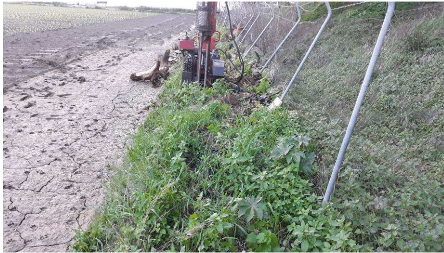
Figura Nº 13.- Emplazamiento del ensayos a penetración dinámica P-01 NORTE.
