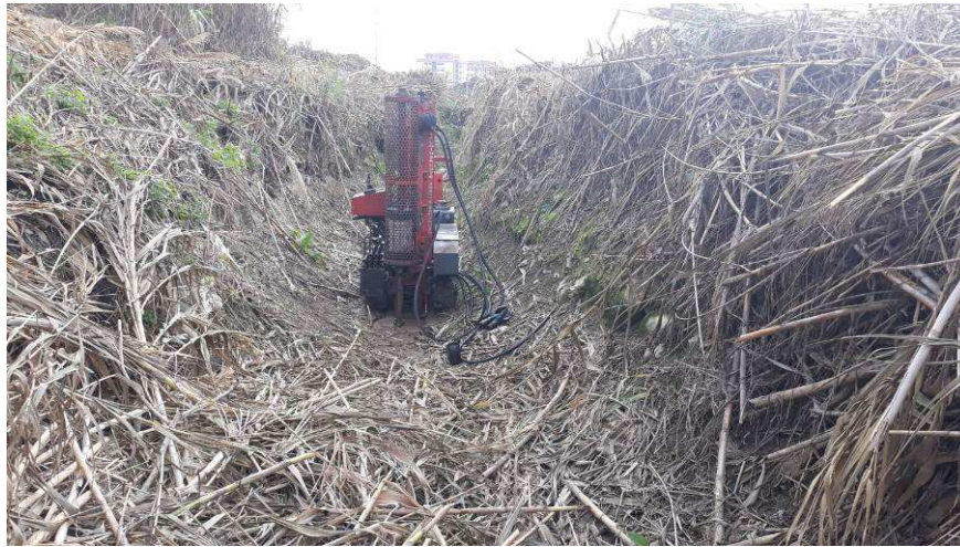
Figura Nº 19.- Emplazamiento del ensayos a penetración dinámica P-07 NORTE.
