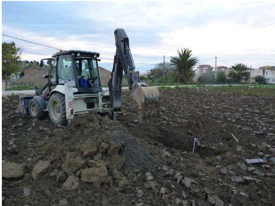
Figura Nº 29.- Emplazamiento de la cata C-04 NORTE.
