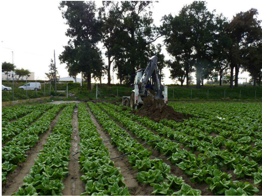
Figura Nº 31.- Emplazamiento de la cata C-06 NORTE.
