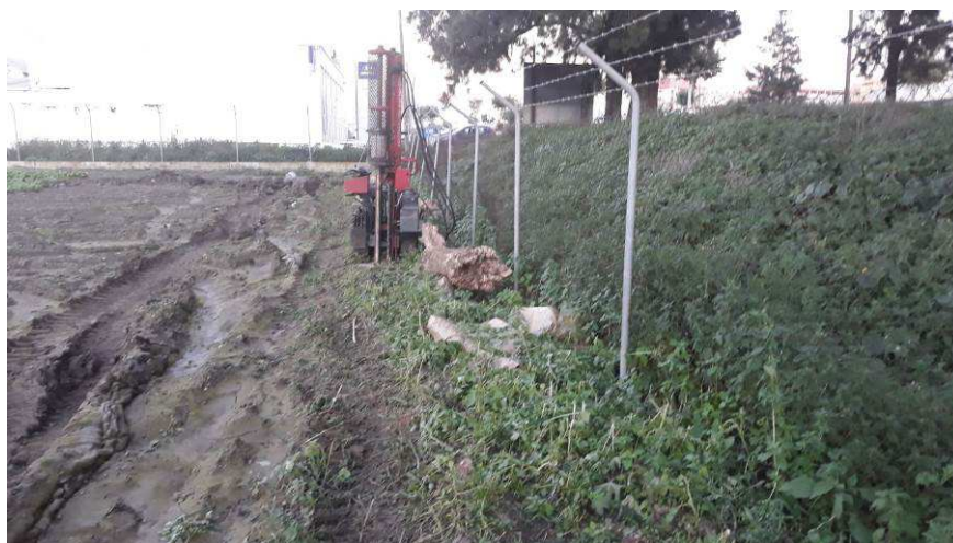
Figura Nº 18.- Emplazamiento del ensayos a penetración dinámica P-06 NORTE.
