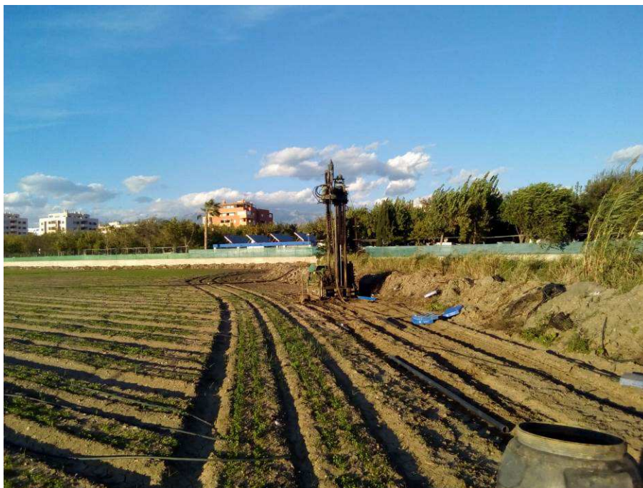
Figura Nº 12.- Emplazamiento del sondeo a rotación S-02.
