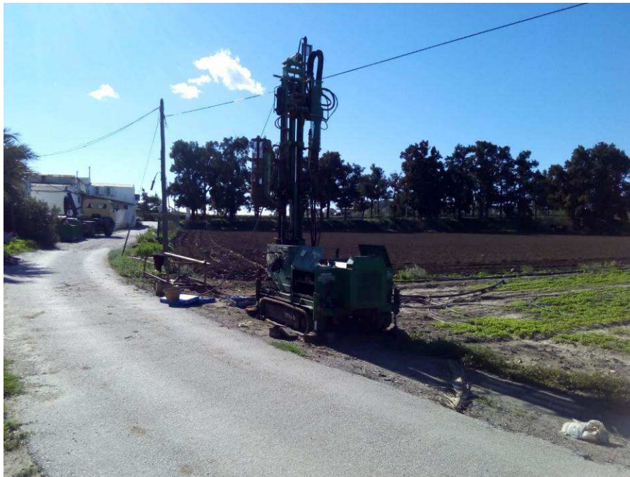
Figura Nº 11.- Emplazamiento del sondeo a rotación S-01.
