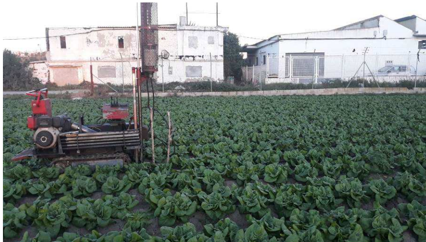
Figura Nº 17.- Emplazamiento del ensayos a penetración dinámica P-05 NORTE.
