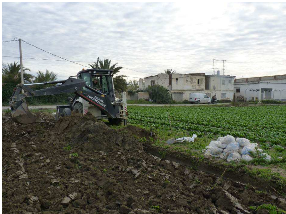
Figura Nº 30.- Emplazamiento de la cata C-05 NORTE.
