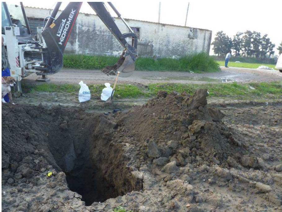
Figura Nº 28.- Emplazamiento de la cata C-03 NORTE.
