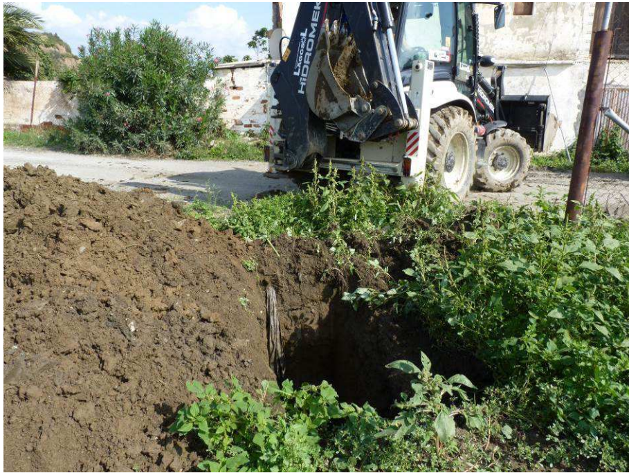
Figura Nº 27.- Emplazamiento de la cata C-02 NORTE.
