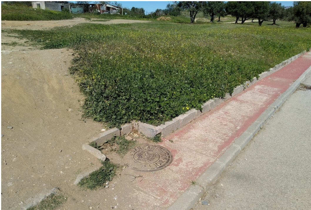
Pozo de pluviales de C/ Moclinejo.
