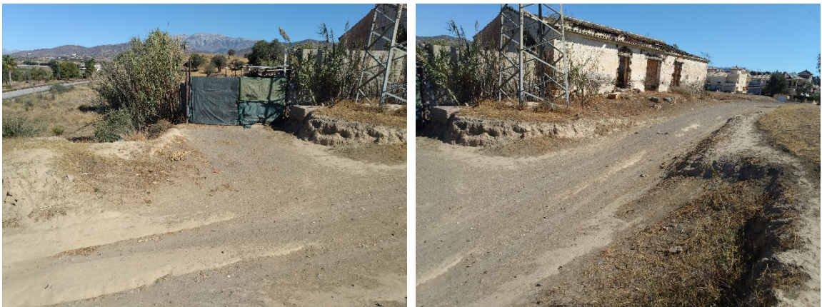
Montaje en el que se aprecia la entrada a parcela y el poste de electricidad en MT.
