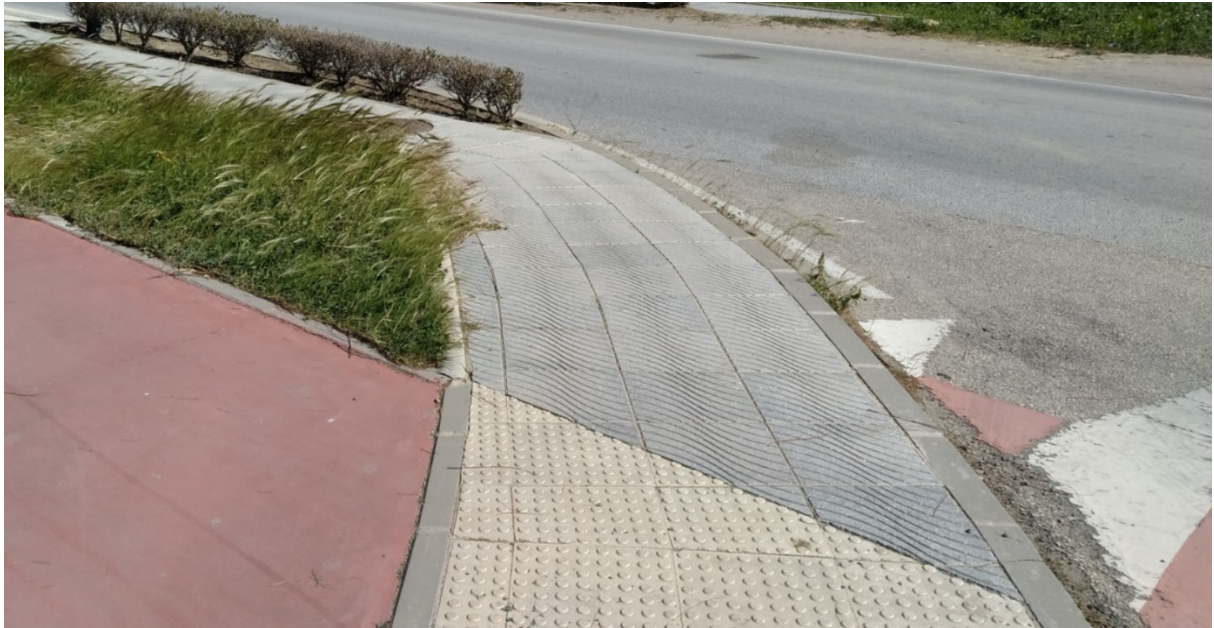
Baldosa hidráulica 40x40 cm en acerado ejecutado.
