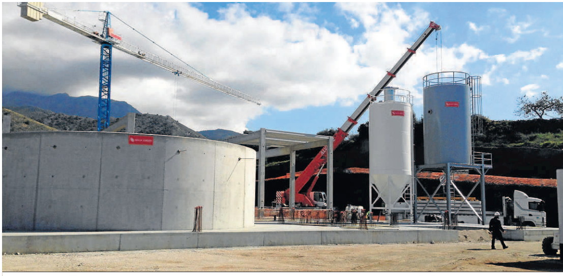
Estado de las obras de la edar del municipio axárquico.
