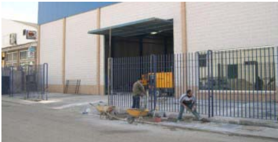
Nave en construcción
