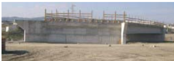
Nuevo Puente sobre Río Seco en terrenos obtenidos por convenio
