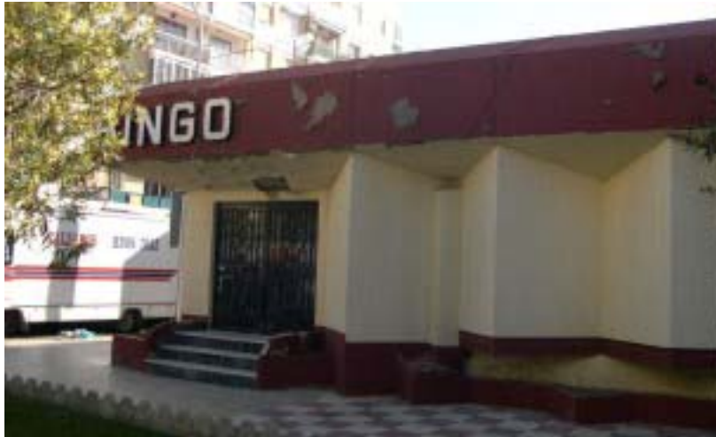
Local para nuevos equipamientos en Torre del Mar
