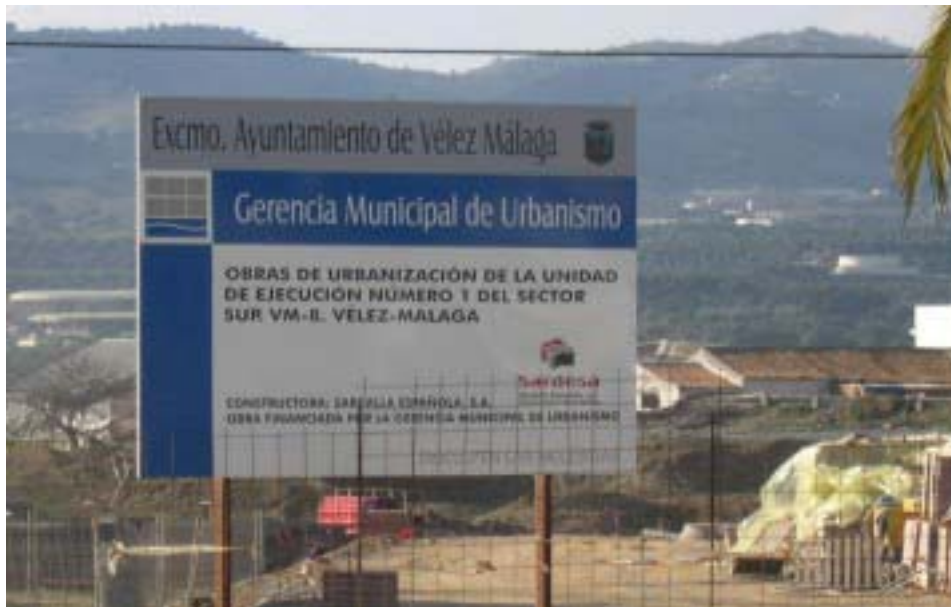
Obras de urbanización en el sector SUP.VM-8 "Ensanche de Vélez Málaga"
