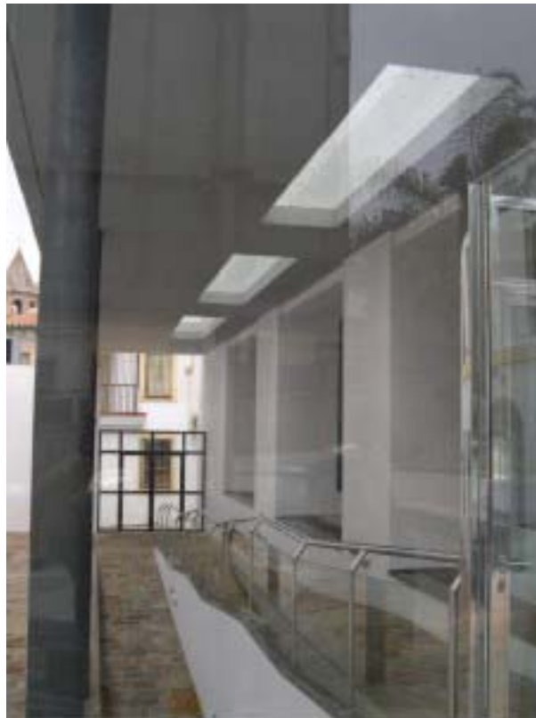
Obras de ampliación del Palacio Marqués de Beniel
