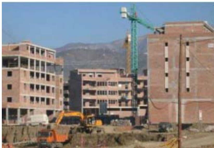
Edificios en construcción en el SUP.VM-8
