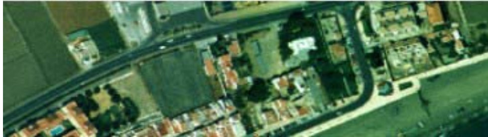
Unidad de Ejecución UE. T-2 "Las Melosas" de Torre del Mar
