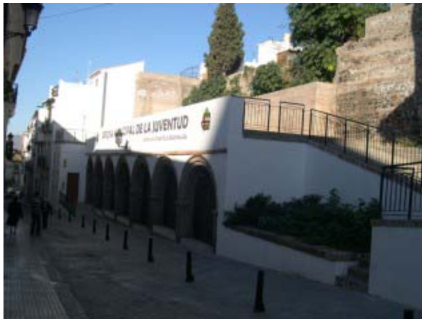
Edificio Municipal. Rehabilitación dirigida por Técnicos de la GMU.
