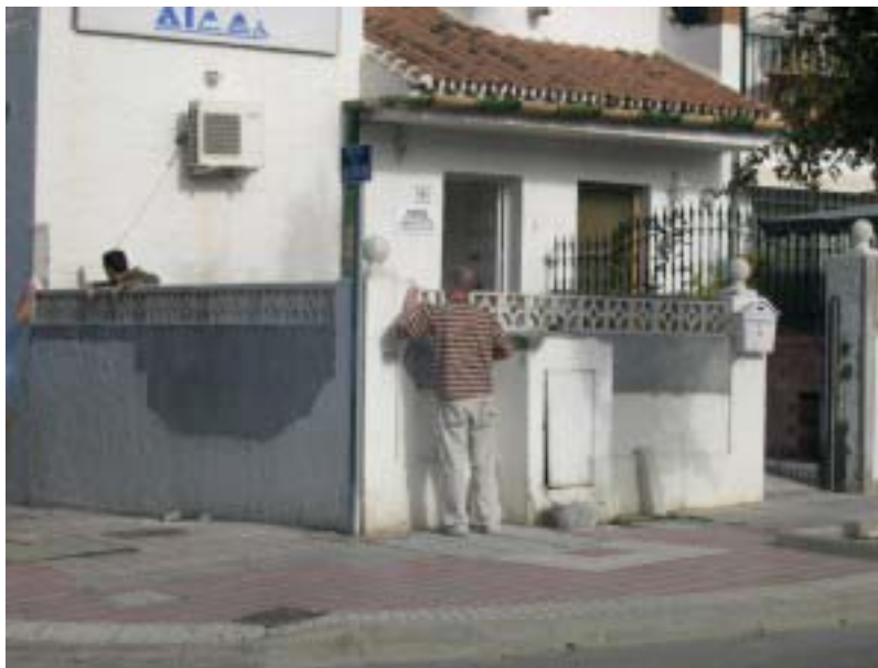
Obra menor en edificación existente
