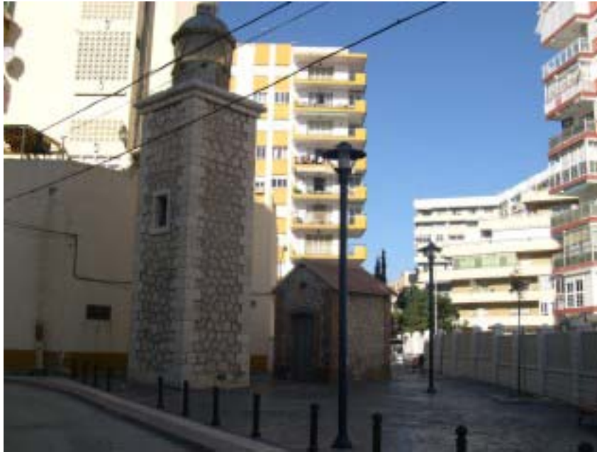
Obras de urbanización entorno del Faro de Torre del Mar
