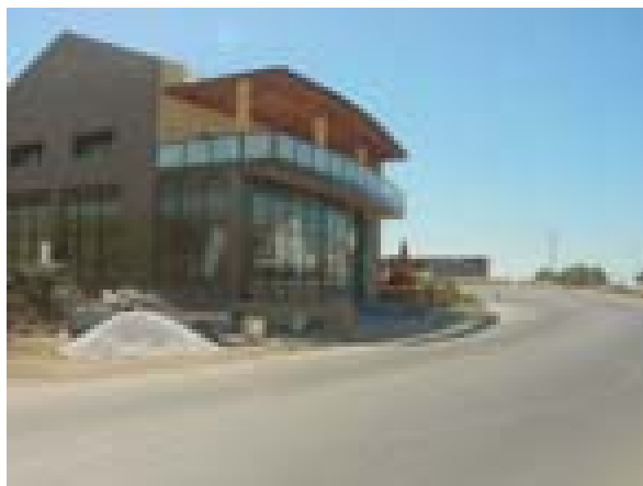
Nave en construcción
