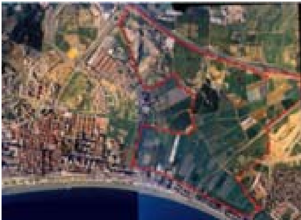
Suelo No Urbanizable en la Vega de Río Seco. Se tramita ME. para su protección.
