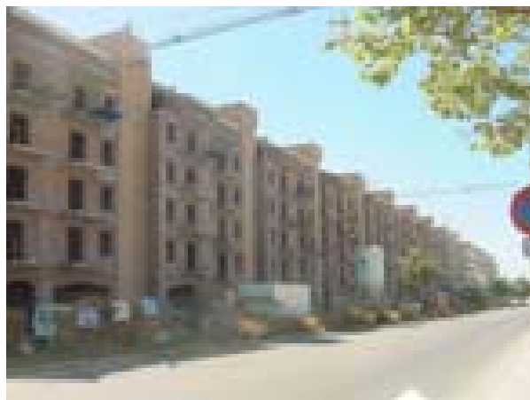
Edificio en construcción.
