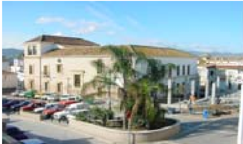
Obras de ampliación del Palacio de Beniel
