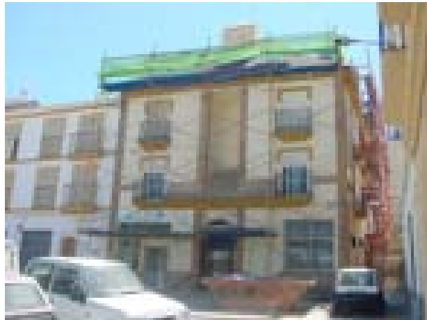
Ejemplo de Edificio Rehabilitado
