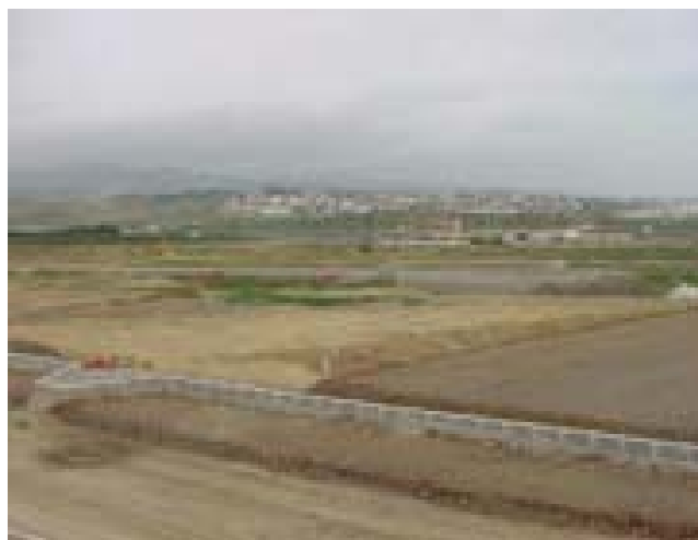
Obras de Urbanización en Ejecución del Planeamiento
