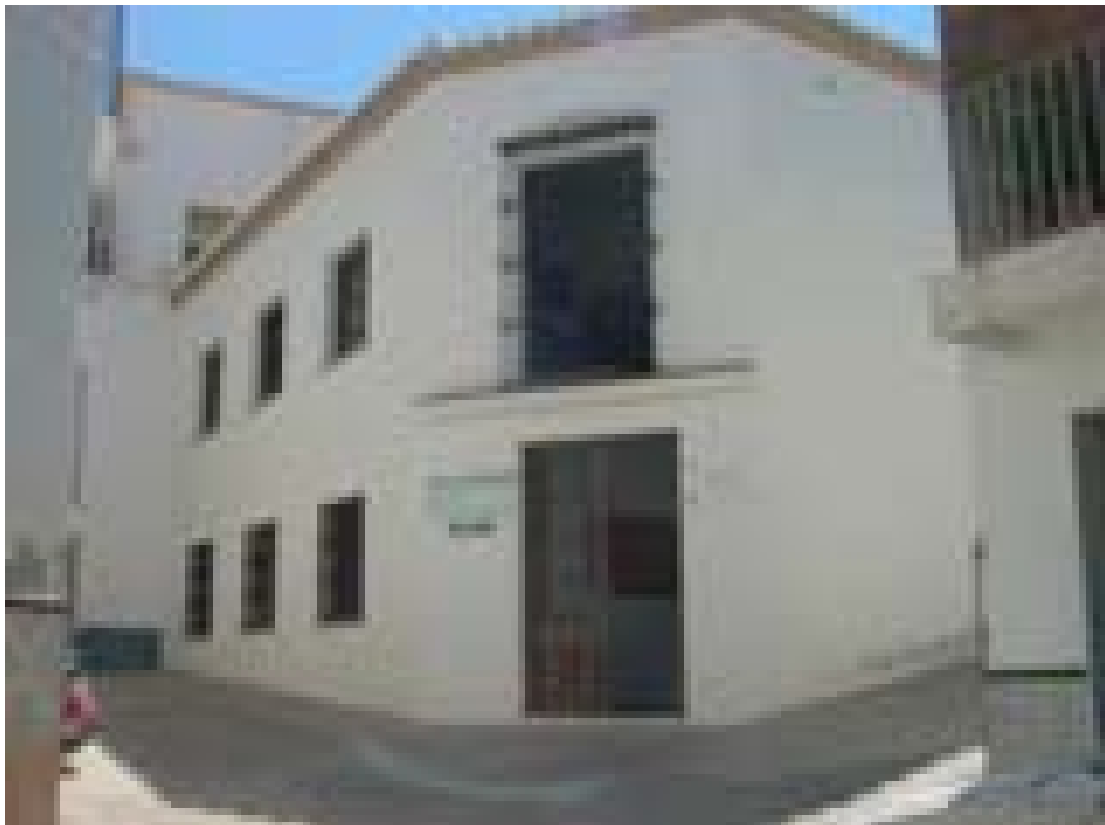
Fachada de la Oficina de Rehabilitación de Viviendas
